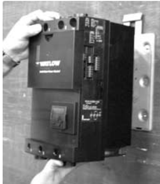
Figura 2 — Instalación del controlador.
