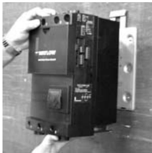
Figuur 2 — Spanningsregelaar installeren.
